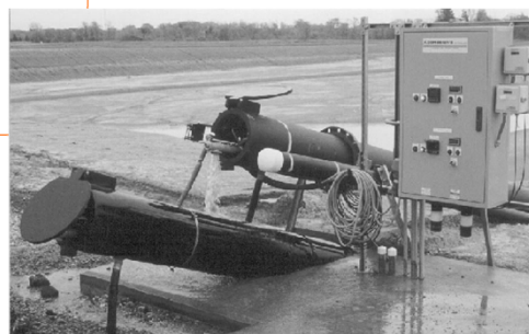
斜井抽排地下水
