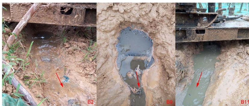
滑坡一年半后滑床钻孔揭露的超孔隙水压力
